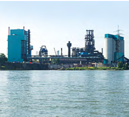
Kohlenstaub-Einblasanlage Hüttenwerke Krupp Mannesmann (DEU)
