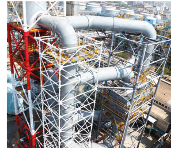
PFA-beschichtete Wärmetauscher zum Einsatz in korrosiven Medien, CPC (TWN)
